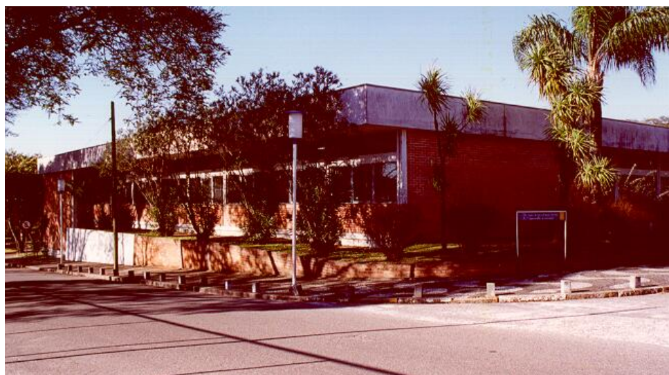
Figura 1: Fotografia do edifício do Departamento de Engenharia Elétrica da UFPR, no Centro Politécnico em, Curitiba.
